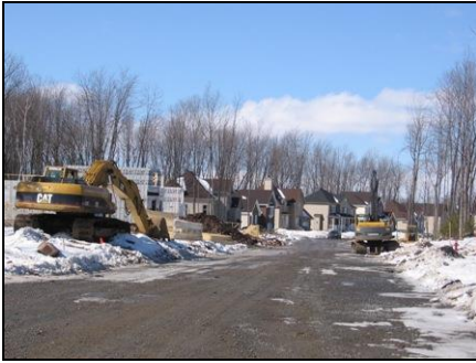
Photo 2 : Développement résidentiel en cours / rue du Suroît
